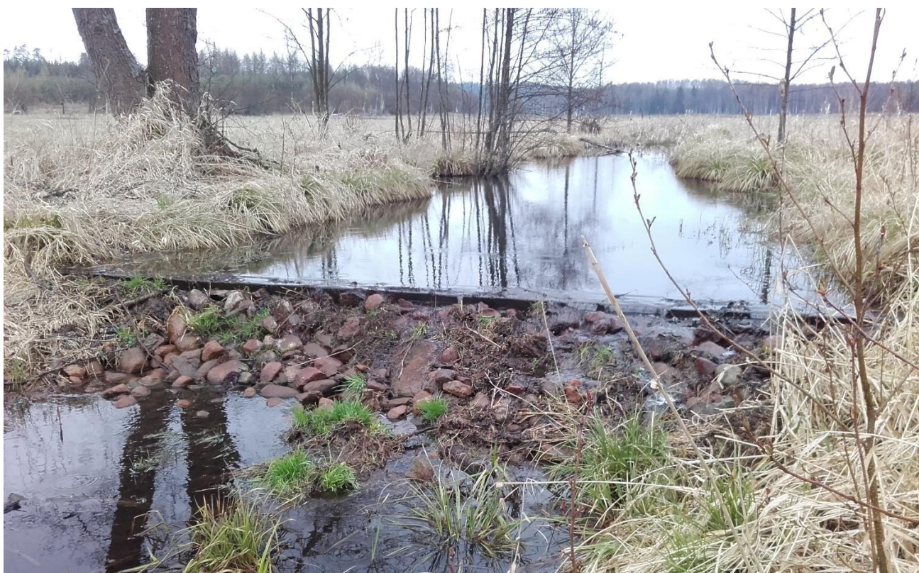
Zastawka piętrząca poziom wody w rowie odwadniającym na mazurskim torfowisku na terenie Nadleśnictwa Maskulińskie. Fot. W. Kotowski.
