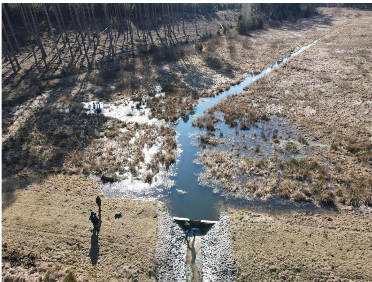
Fot. 3. Próg piętrzący wybudowany w ramach projektu, widoczna jest różnica poziomu wody przed i za urządzeniem (fot. Mariusz Lamentowicz).
