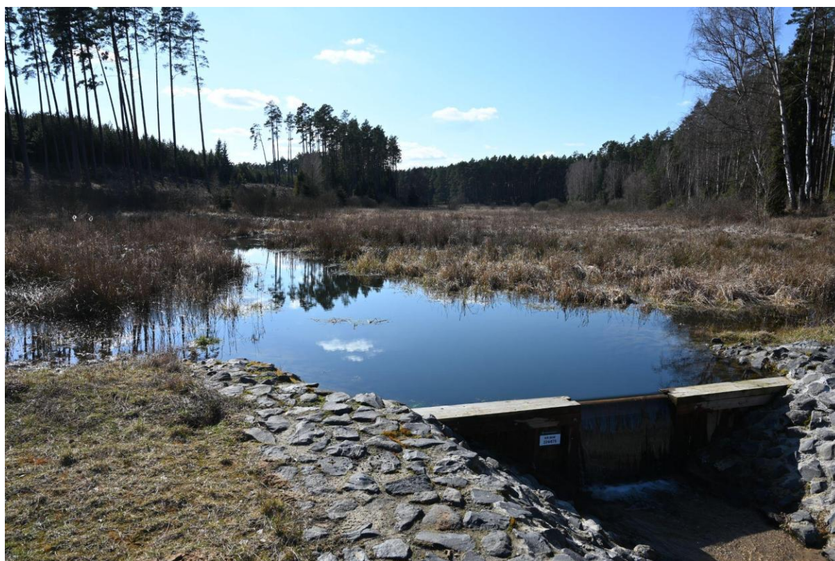
Fot. 2. Próg piętrzący wybudowany w ramach projektu, widoczna jest różnica poziomu wody przed i za urządzeniem (fot. Mariusz Lamentowicz).
