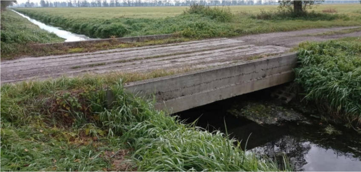
Ryc. 38. Most betonowy na jednym z odprowadzalników (fot. Sz. Chmur).
