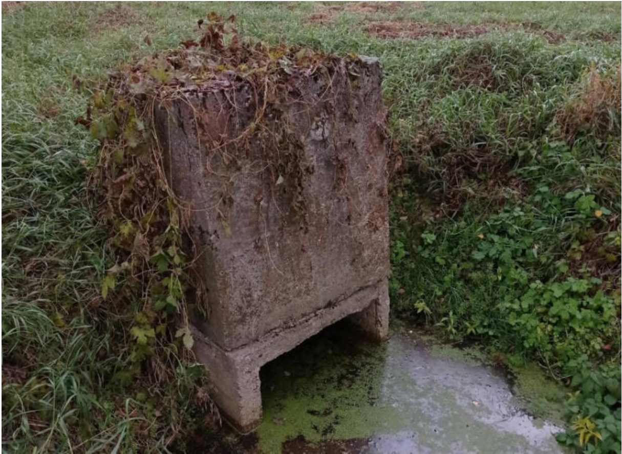
Ryc. 37. Przepust betonowy z pozostałościami mnicha (fot. K. Wojtas).
