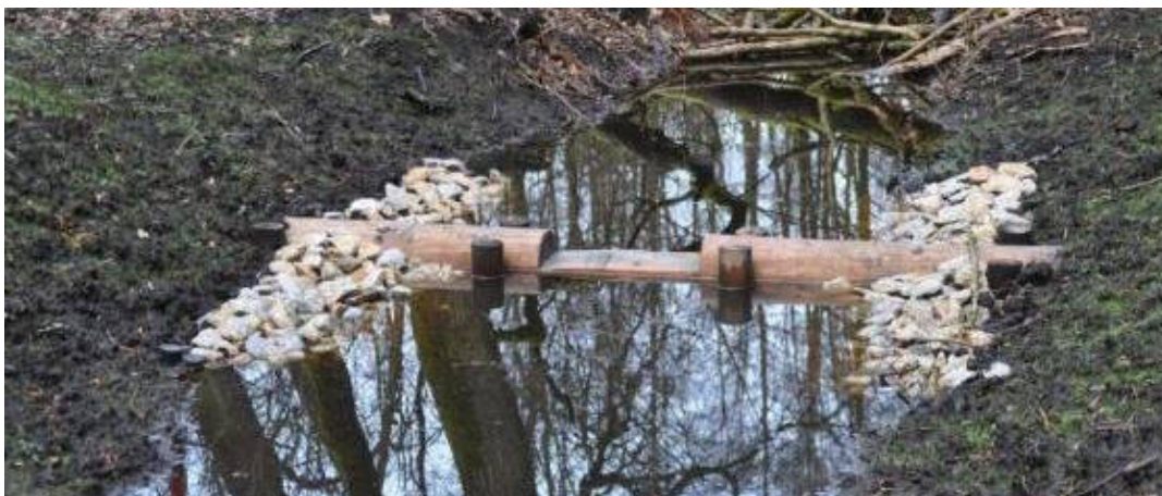
Ryc. 82. Przykład progu spowalniającego odpływ wód powierzchniowych zamontowanego w nadleśnictwie Babimost w ramach projektu Mała retencja nizinna (źródło: babimost.zielonagora.lasy.gov.pl ).
